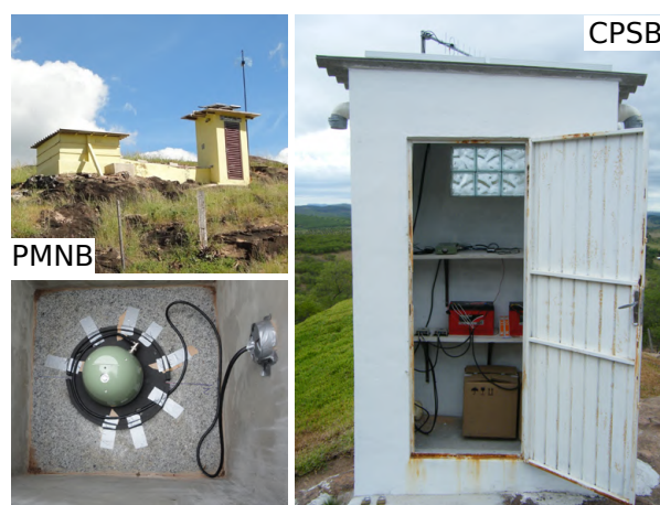
Figura 2: Exemplo de estação e equipamentos instalados. Vista geral da estação PMNB (Patos de Minas/MG) sobre afloramento de rocha dura: à esquerda caixa de terra cobrindo o sensor, à direita cabine com registrador e acessórios (a); Abrigo dos equipamentos na estação CPSB (Caçapava do Sul/RS) e (c) Sensor Nanometrics Trillium 120PA instalado no abrigo de uma estação.
