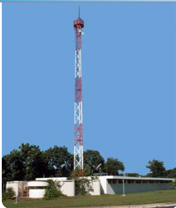
Torre 1 do Observatório Sismológico da UnB.
