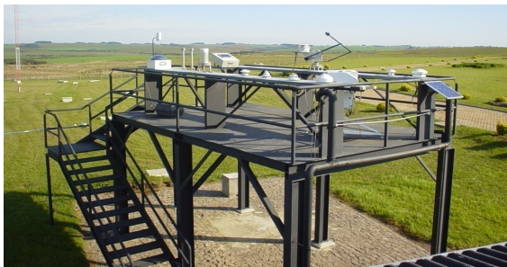
Figura 2: Vista panorâmica da plataforma da estação de referência do Projeto SONDA instalada no Observatório Espacial do Sul OES/CRS/INPE - MCT, em São Martinho da Serra - RS.
