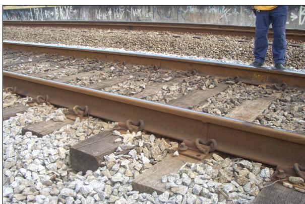
Figura 05: Lastro aparentemente novo no Km 29+600.
