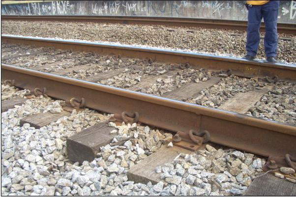
Figura 13: Lastro aparentemente novo no Km 29+600.
