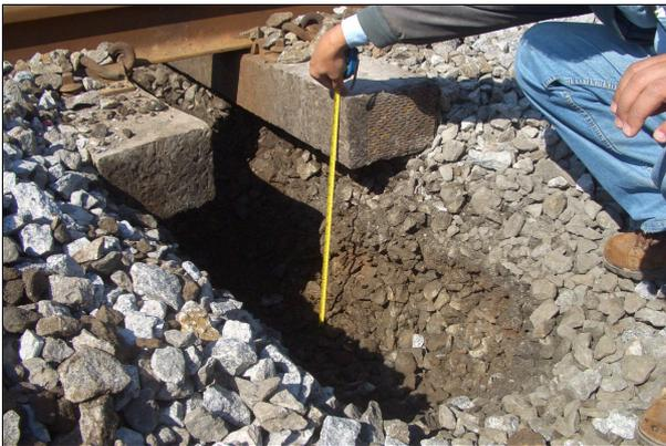
Figura 14: Medição da espessura da camada de lastro e intermediária no Km 29+600.
