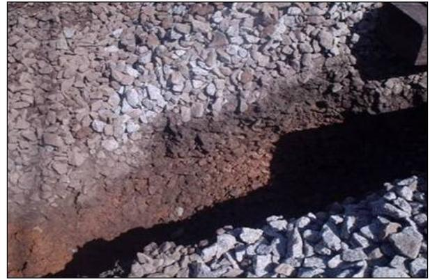
Figura 15: Presença de finos e umidade nas camadas de lastro e intermediária no Km 29+600.
