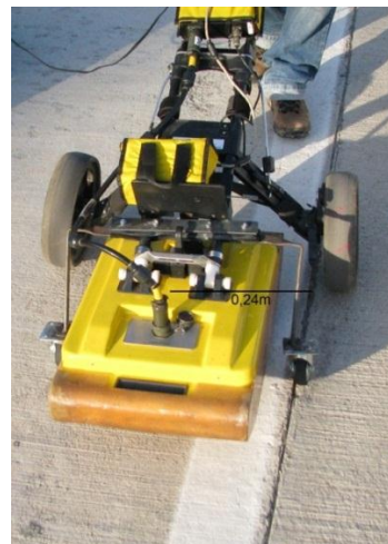
Figura 3 – Foto evidenciando o posicionamento do equipamento GPR ao longo da junta de dilatação localizada entre a faixa de segurança e a faixa de rolamento.
