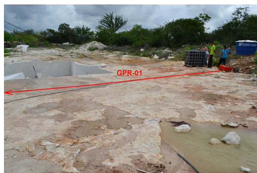
Figura 6: Vista da área com a trajetória do perfil GPR-01, investigando a subsuperfície do maciço onde uma empresa tenciona implantar futura lavra de blocos de rochas ornamentais.
