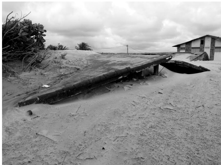
Figura 2 – Residência soterrada por sedimentos arenosos na Praia de Barra do Rio, Extremoz/RN.
