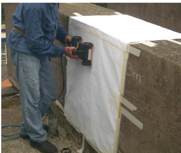
Foto 2 – Ensaio de radar executado em lateral de viga.
