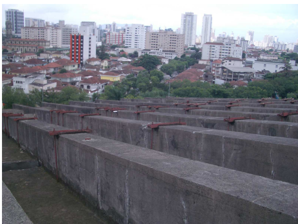
Foto 1 – Vista geral da cobertura da edificação.
