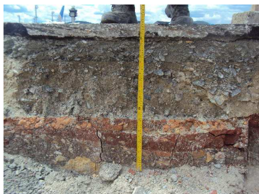
Foto 2 – Camadas do pavimento do pátio do estacionamento mostrando a capa asfáltica, a camada de brita graduada tratada com cimento, a camada de brita graduada simples e a camada de solo compactado.
