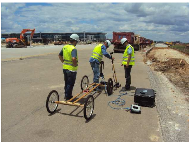
Foto 1 – Ensaio com radar no pátio do estacionamento.
