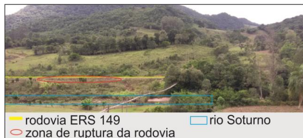
Figura 2 - Encosta onde foi realizada a campanha geofísica e demarcações de localização da rodovia ERS 149, zona de ruptura da rodovia e o rio Soturno.
