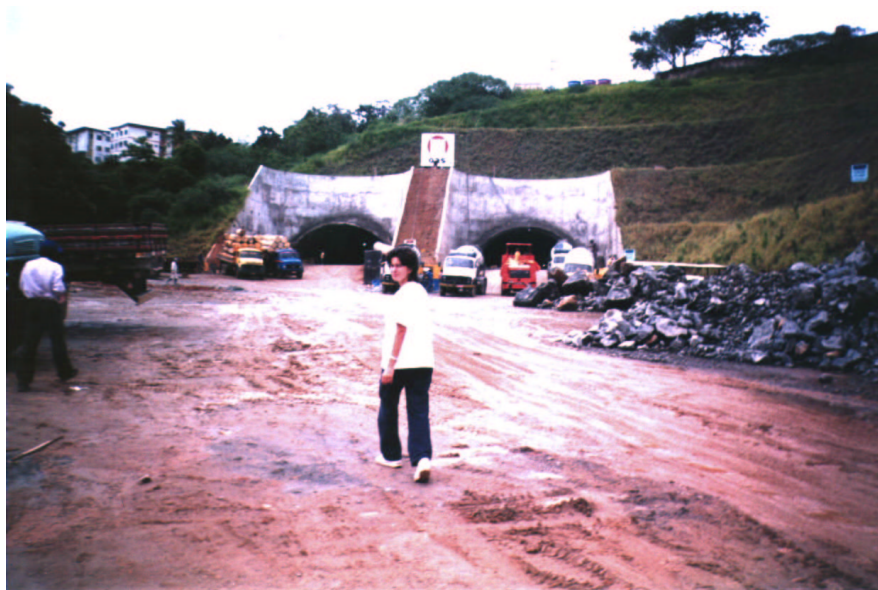
Figura 4: Tunnel de ligação Limoeiro-Jaguaribe, emboques Norte. Os prédios monitorados são vistos à esquerda na parte superior. Do centro para a direita, vista dos taludes dispostos com 4 bermas em diferentes níveis. Solos argilosos (regolito) derivados de rochas granulíticas.
