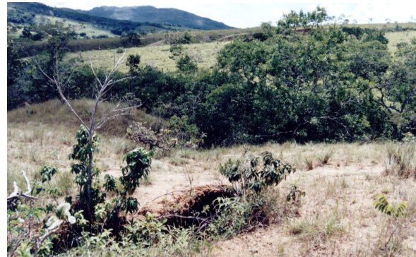
Figura 1 – Fotografia da vertente apresentando a abertura do duto na superfície.
