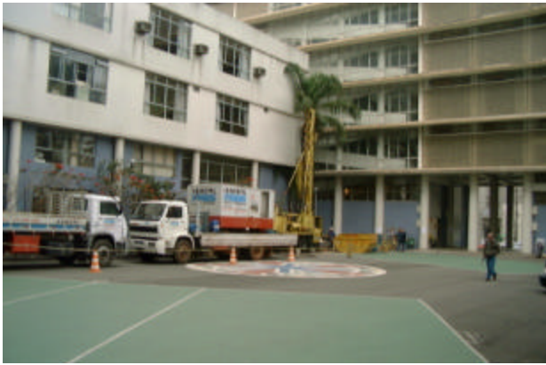
Figura 6 – Localização do poço na campus Reitoria.
