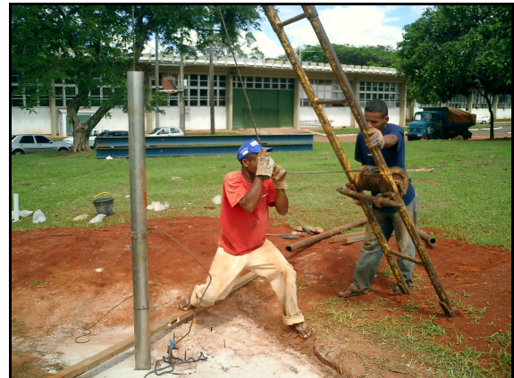
Figura 4 - Construção das estacas.
