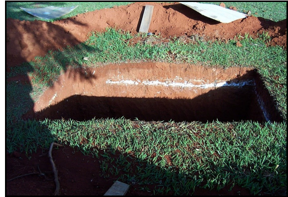
Figura 2 - Abertura da vala.
