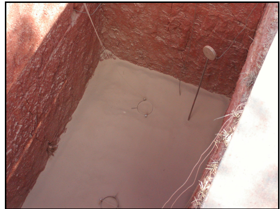
Figura 3 - Deposição das camadas de areia.
