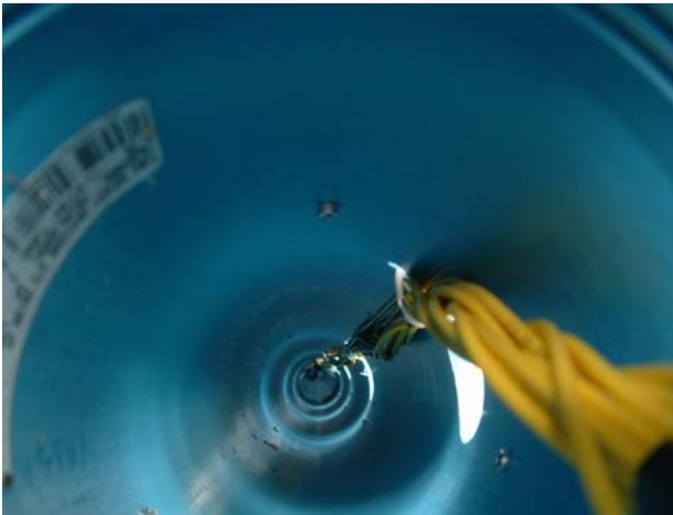
Foto 2. Disposição interna dos cabos de ligação dos eletrodos no revestimento dos poços multi-eletrodos.
