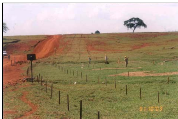
Figura 1: Delimitação do trecho de estudo da dutovia e espaçamento de estacas. Nota-se a presença de pequeno depósito aluvionar próximo ao curso d'água, ambos dentro da área de estudo.
