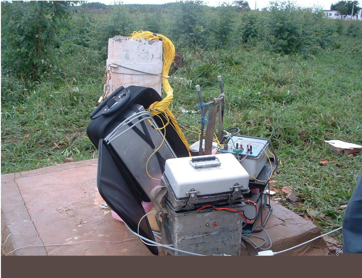
Figura 4 – Protótipo da matriz de comutação de eletrodos e suas conexões aos diversos eletrodos do poço e também ao medidor de resistividade e IP SYSCAL R2. No detalhe, o cabo RS-232 de comunicação com o PC
