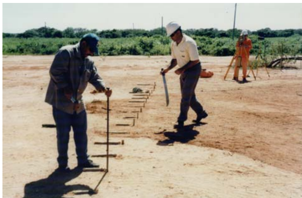
Figura 2 – Demarcação e levantamento plani-altimétrico do 3D de GPR.
