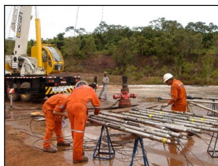
Figura 4. Preparação dos receptores (VSI) antes da descida em um dos poços.
