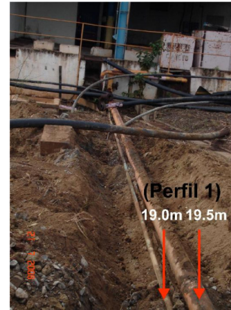
Figura 4 – Imagem mostrando duas tubulações e suas distâncias no perfil 1.
