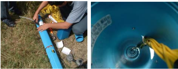
Fotos 1 e 2. Disposição de eletrodos e cabos no revestimento dos poços.
