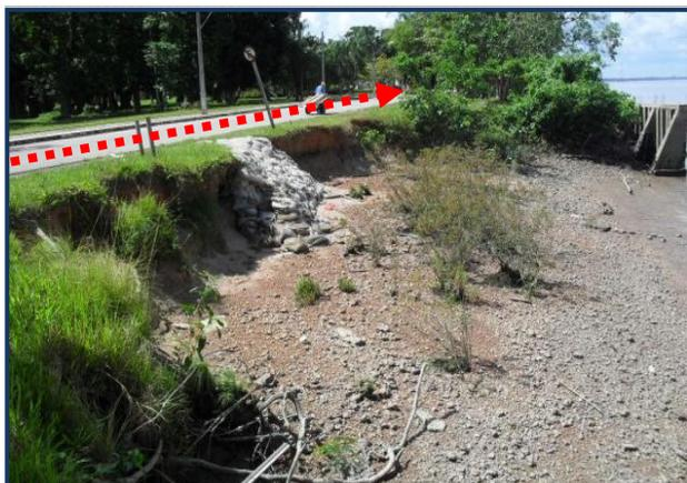
Figura 2 - Grande erosão já chegando á pista, de 110 a 145 m, com sacos de cimento, localizado entre 125 e 130 m.
