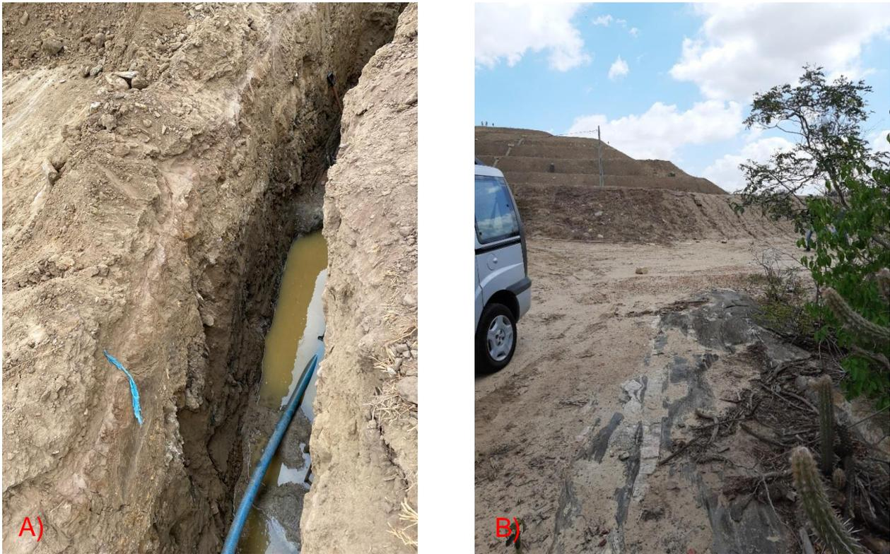
Figura 7 – A) Trincheira com saturação de líquidos a aproximadamente 4 metros de profundidade nas imediações da posição 176 m da linha 1. B) Dique subvertical de rocha gnáissica correspondente à feição resistiva aflorante na posição 44 m da Linha 3.
