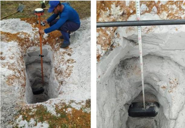
Figura 6: Escavação para conferência do duto: verificação de profundidade e posicionamento.
