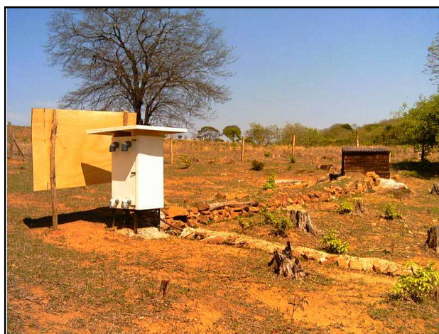
Figura 1 – Estação instalada em Correntina– BA. O sensor está enterrado sob uma caixa de madeira à direita, e o registrador está na cabine branca à esquerda com um painel solar como teto.
