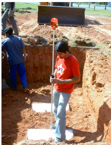
Figura 1 – Instalação de tambores metálicos na horizontal.
