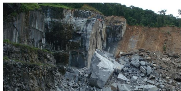
Figura 1 – Deslizamento de parte do talude que soterrou o maquinário. É possível notar alguns veículos no centro da imagem como fator de escala (GALLI; CAMPOS; SOUSA, 2013).
