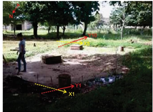
Figura 2. Fossa séptica nas áreas de Universidade Federal do Oeste do Pará.
