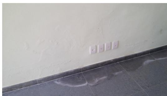
Figura 3 - Presença de infiltrações dentro da sala J0-011.
