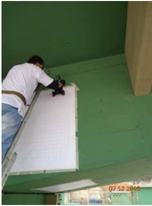
Foto 2. Ensaio de radar sobre a parede lateral do viaduto.
