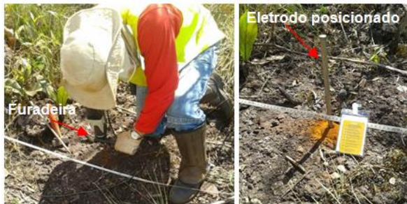
Figura 2 – Fotografias evidenciam o uso de furadeira para a inserção de eletrodos metálicos no subsolo.
