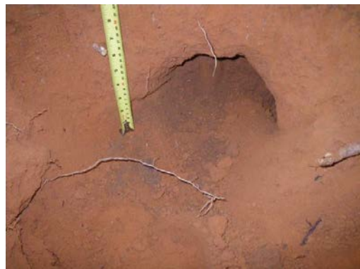
Figura 8 – Cavitação parte da rede de túneis de animais associada ao Alvo 1.1.
