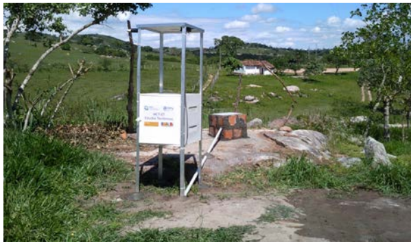
Figura 2- Rede BM2010, estação (BMCR) que esteve em operação no distrito de Cachoeira do Riachão em São Joaquim do Monte - PE. O sismômetro encontra-se dentro da estrutura de alvenaria. O registrador encontra-se dentro da caixa branca.
