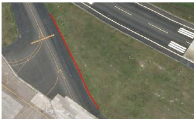
Figura 3 – Localização na imagem aérea da seção 724.
