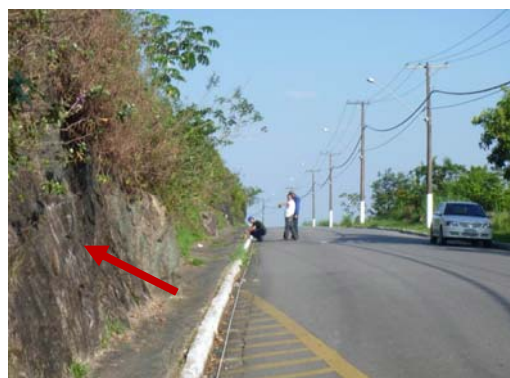
Figura 6 - Corpo rochoso com forte mergulho (apontado pela seta, no lado esquerdo da via). O traçado da adutora encontra-se sob o lado direito da foto (mais próximo ao veículo estacionado).
