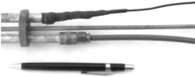
Fig. 2 – Detalhe das conexões elétrica e pneumática nas extremidades dos tubos guia.
