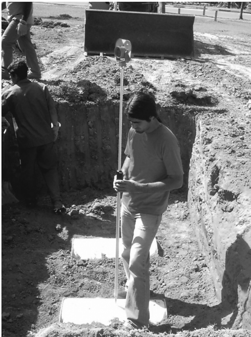
Figura 5 – Levantamento topográfico dos alvos instalados no SCGR-IAG.
