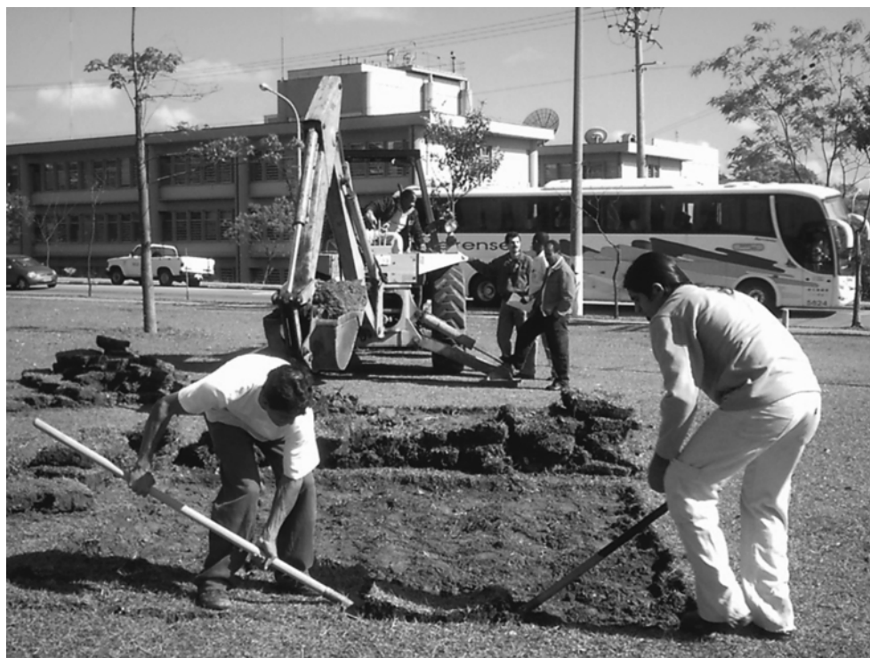
Figura 3 – Instalação dos alvos no SCGR-IAG.
